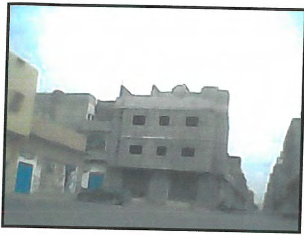
مبنى قيد الإنشاء
