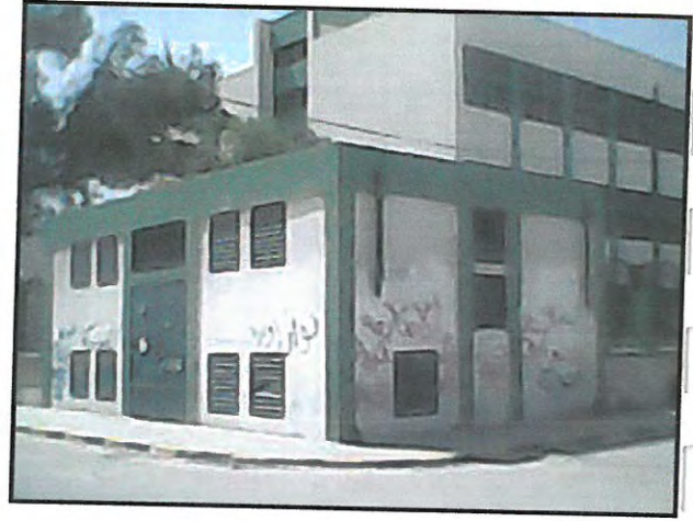
محطة توزيع كهرباء بجانب مدرسه
