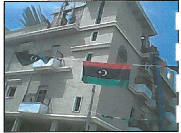
مبنى حديث الطراز (فيلا)
