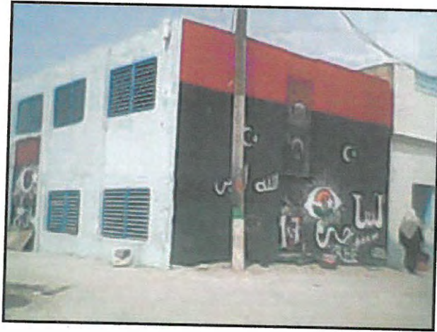
محطة توزيع كهرباء بجانب مسكن
