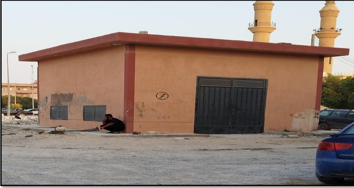
الصورة ( 3 ) غرفة محطة فرعية بداخلها محولات بمدينة اجدابيا
