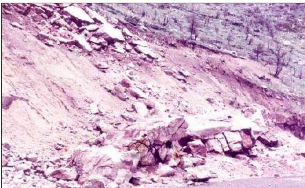
الشكل (الشكل 29.8) صورة توضح الإنهيار الكامل للجدار الذي يحمي السفح وإنجراف كامل للسفح الذي يحمل الطريق بعد موسم مطري واحد ( عقرة - محافظة نينوى)
