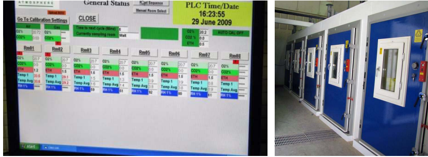
شكل (١١). غرف تخزين حديثة مزودة بتقنيات التحكم في أجواء التخزين (يمين) وشاشة عرض بيانات التحكم في درجة الحرارة والرطوبة النسبية ونسب الغازات (يسار). (المصدر: الحمدان وآخرون، ٢٠١٠).
