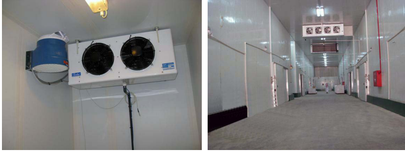
شكل (١٠). غرف تبريد حديثة (يمين) وجهاز التبريد بالماء يعمل بالتحكم الآلي لزيادة الرطوبة النسبية داخل المخزن (يسار). (المصدر: تصوير المؤلفين).
