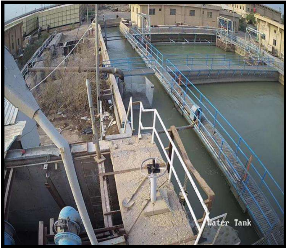
اللوحة(19) الطرق التقليدية لتجميع المياه في احواض مكشوفة داخل مشروع ضخ مياه البدعة(محطة الأرزير في البصرة).
